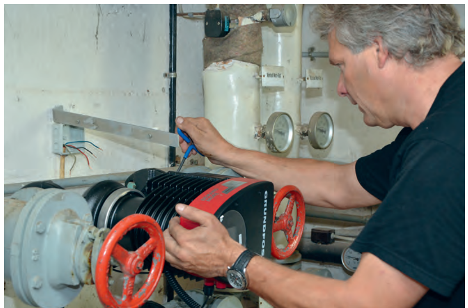
Für den bequemen Einbau lässt sich der Pumpenkopf der Magna3 einfach per Spannring lösen und ausrichten.
