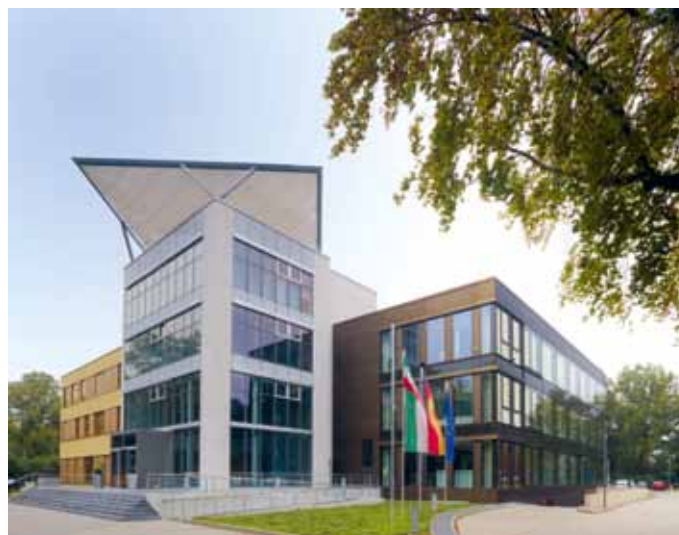
Abbildung 7: PCM in dezentralen Fassadengeräten im Projekt InHaus 2, Duisburg.
