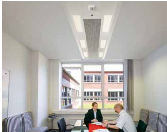
Abbildung 10: Multifunktionales Deckensegel als Ausgangsbasis für eine PCM-Integration, Quelle: Krantz Komponenten.
