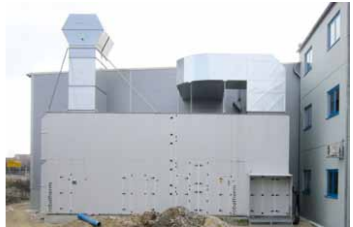
Abbildung 3: Be- und Entlüftungsgerät, 75.000 m³/h.
