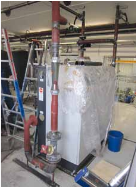
Abbildung 7: Wasser/Wasser - Wärmepumpe.
