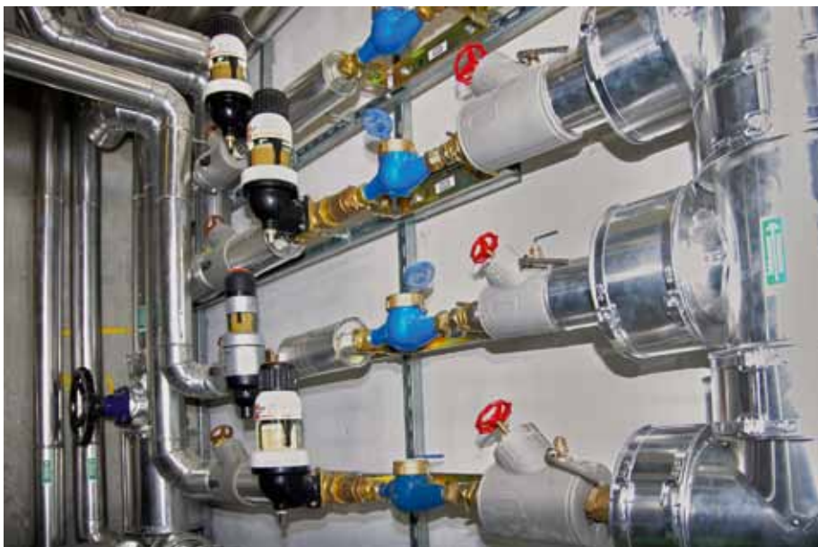
Bild 2: Normgerechte Trinkwasser-Installation.
