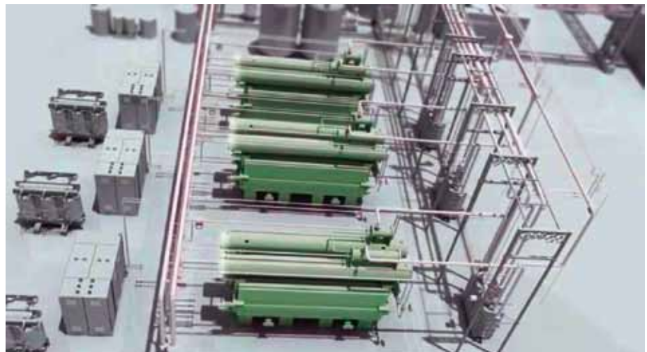
Bild 5: Drei Elektrolyseure der e-Gas-Anlage Werlte (Alkali-Elektrolyse bei Umgebungsdruck; eingesetzte elektrische Leistung jeweils etwa 2 MW) .
