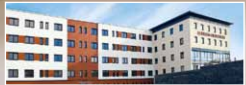
Klira Klinik-Röhrenradiatoren, lasergeschweißt, im kompletten Objekt Neubau Klinikum Hildesheim
