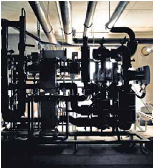
Kompaktfernwärmestation.
