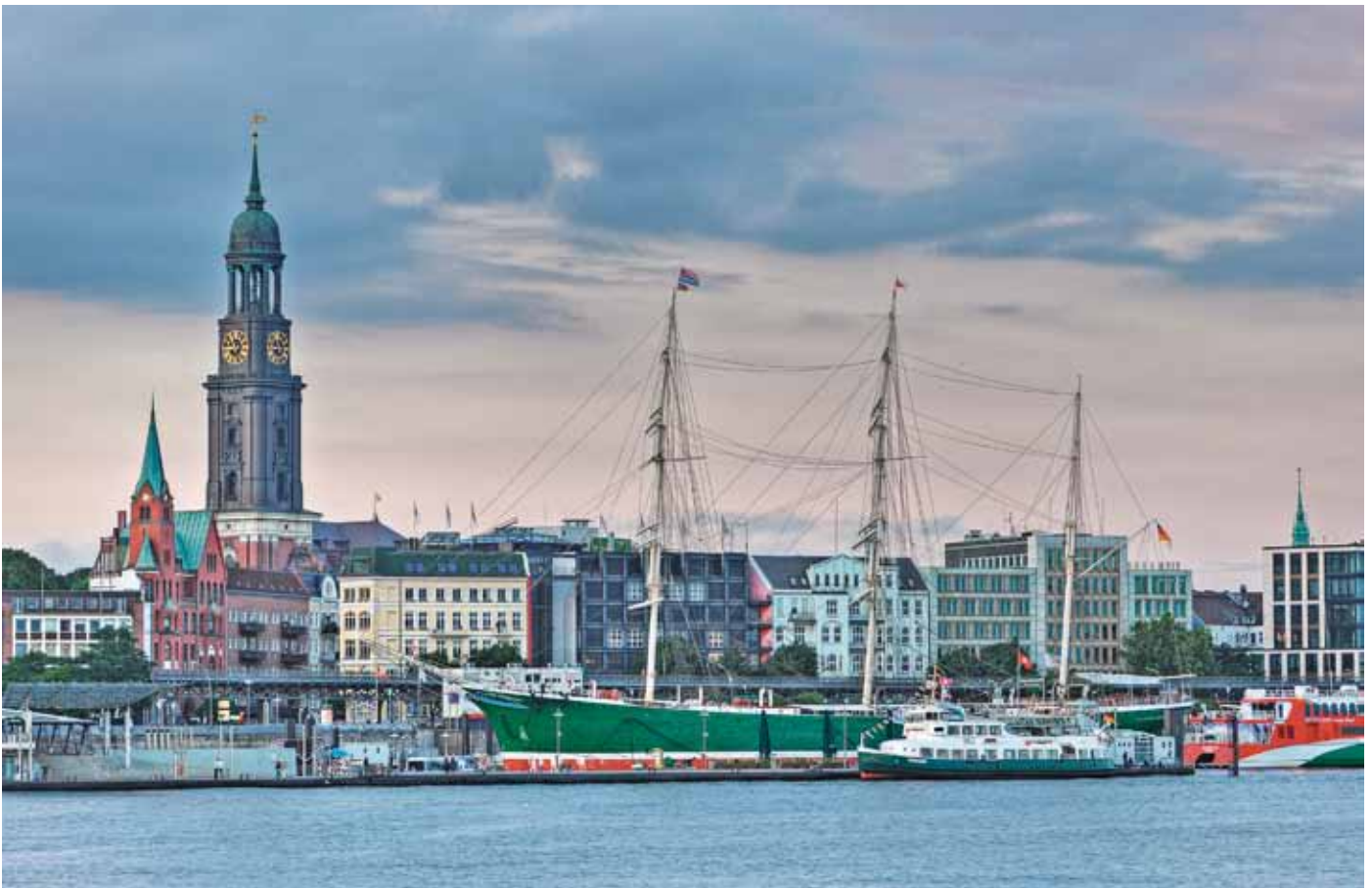
Bild 3: Moderne Gebäudeleittechnik sorgt für gutes Klima im „Michel“, dem Wahrzeichen von Hamburg.
