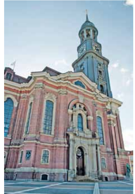
Bild 2: SBC-Gebäudeleittechnik hinter barocker Fassade. © FotoHamBorg - Fotolia.com
