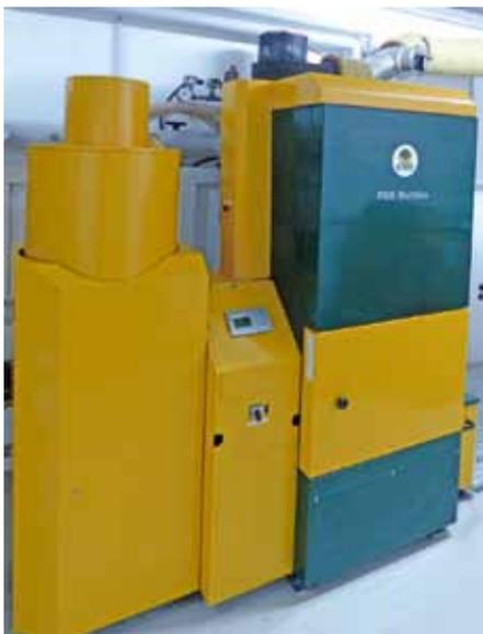
Abbildung 3: Pelletkessel mit Pufferspeicher.
