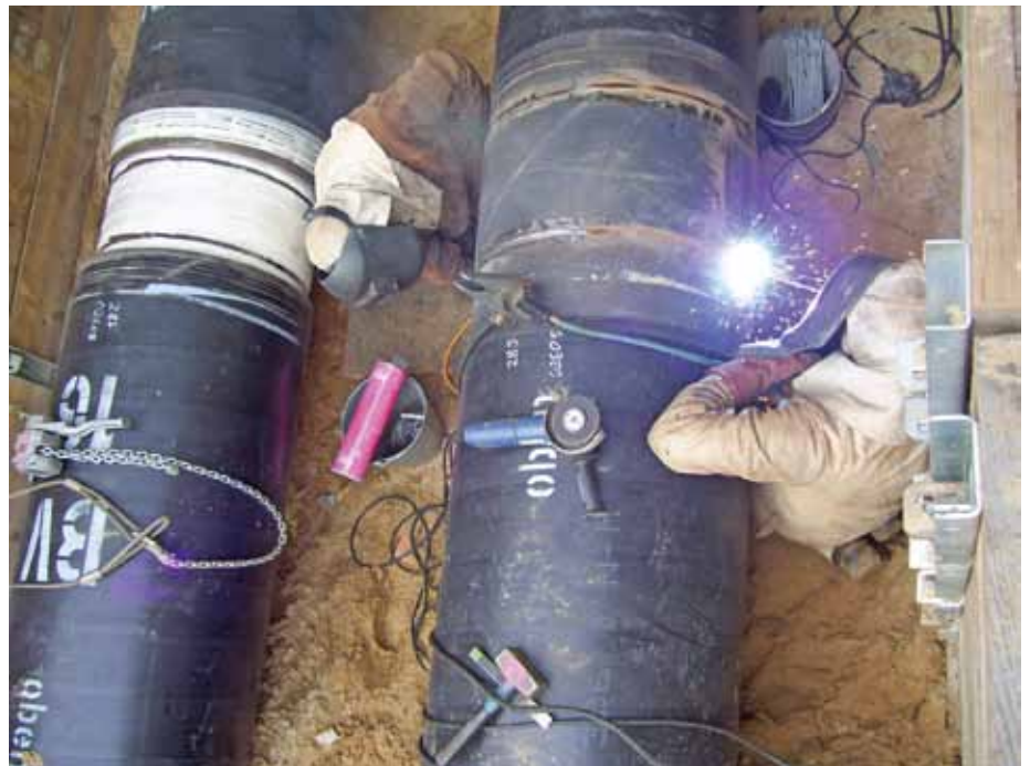
Abbildung 2: Facharbeiter bei Schweißarbeiten an einer Fernwärmeleitung.
