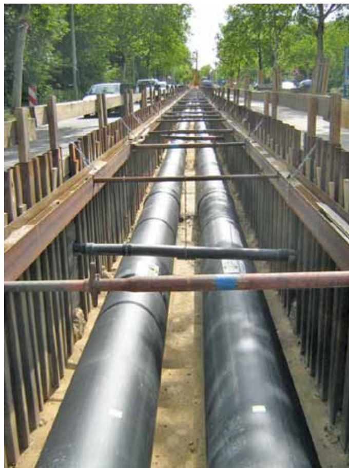
Abbildung 1: Fernwärmebaustelle im Umfang einer FW 1. (Quelle: Vattenfall Europe Wärme AG Berlin)
