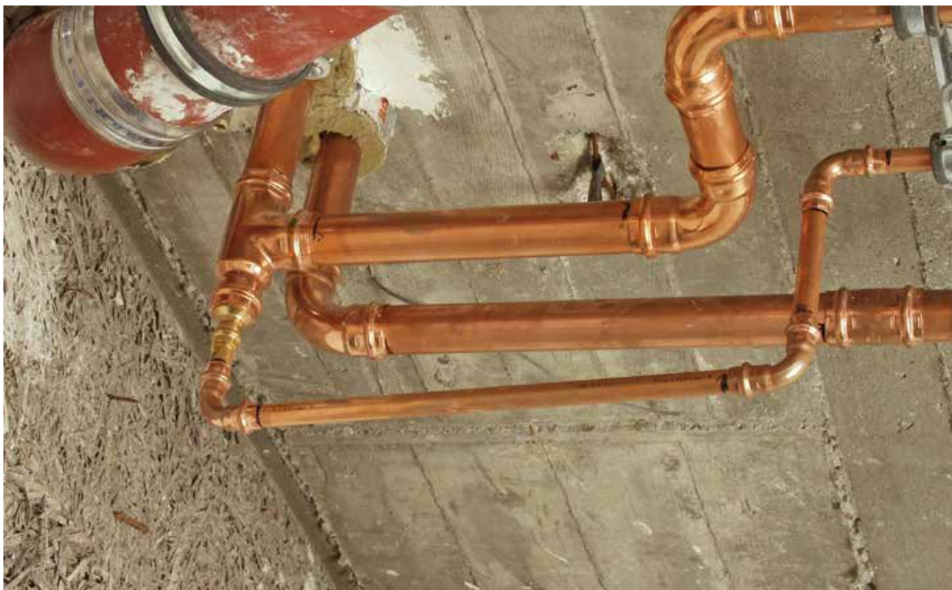
Abbildung 1: Blick auf eine Inliner-Installation mit Kupferrohr. Deutlich erkennbar ist der Platzgewinn, weil auf den zweiten Steigestrang verzichtet werden konnte.
