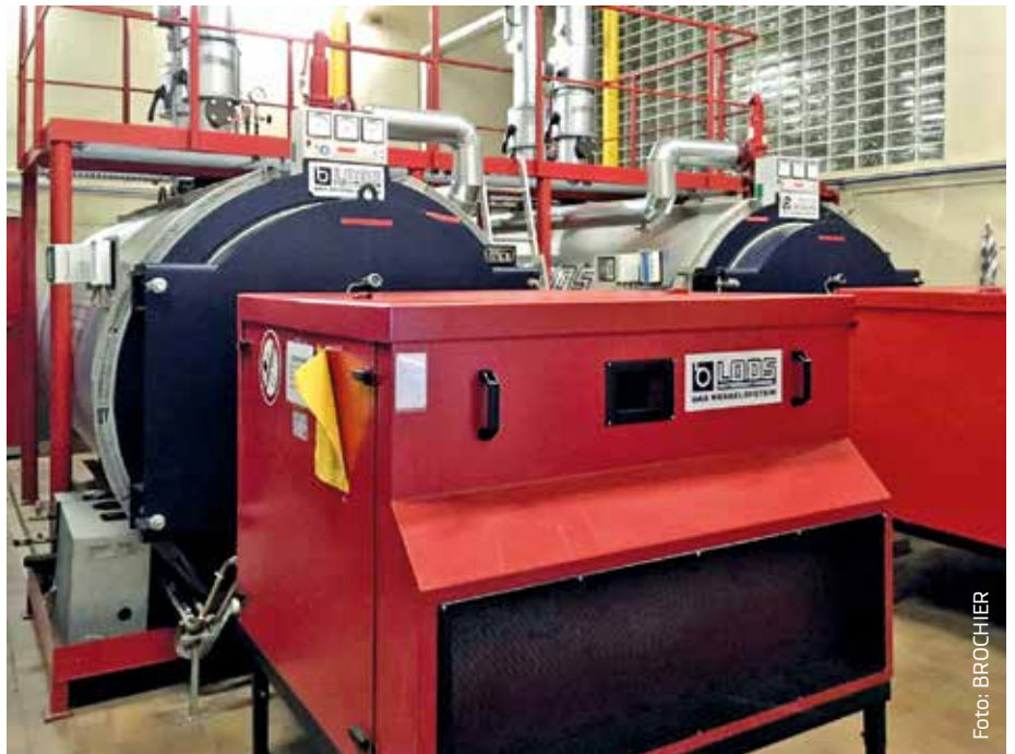
Die Kesselanlage mit Zweistoffbrenner und einer Heizleistung von zweimal 2,2 MW Heizleistung versorgt 26 Gebäude mit bis zu 18 Stockwerken.
