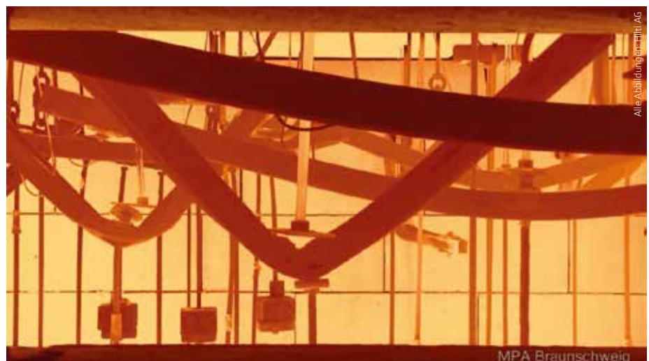
Abbildung 1: Verformungen von Montageschienen unter erhöhten Temperaturen
