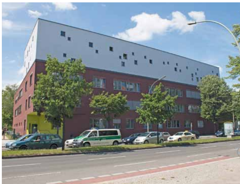
Der Neubau der evangelischen Grundschule in Berlin-Wilmersdorf verfügt über eine fortschrittliche Heizungsregeltechnik.
