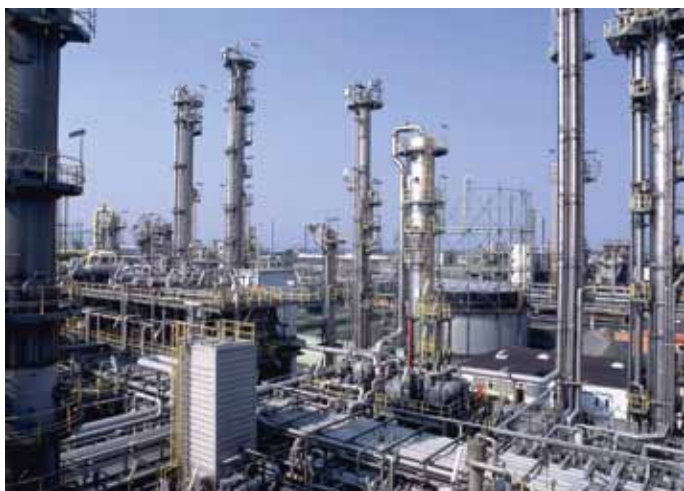
Bild 1: Im Gebäudemanagement, der Wasserversorgung und beim Betrieb von Industrieanlagen gehen etwa 10 % des weltweit verursachten Stromverbrauchs auf das Konto von Pumpen.
