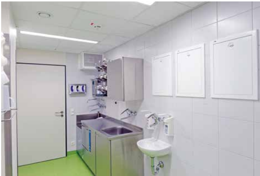
Abbildung 4: Zentraler Bestandteil des Trinkwasser-Hygieneconzepts des Allgemeinen Krankenhauses Celle: Die hoch komplexe Trinkwasser-Installation wurde in sanitärtechnische „Funktionseinheiten“ zerlegt und durch realistische Gleichzeitigkeiten „schlanker“ ausgelegt.
