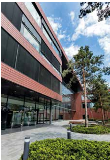
Das Atrium erstreckt sich über alle vier Etagen.
