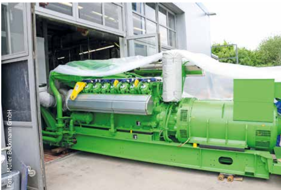
Abbildung 2: Einbringen des Erdgas-BHKW
