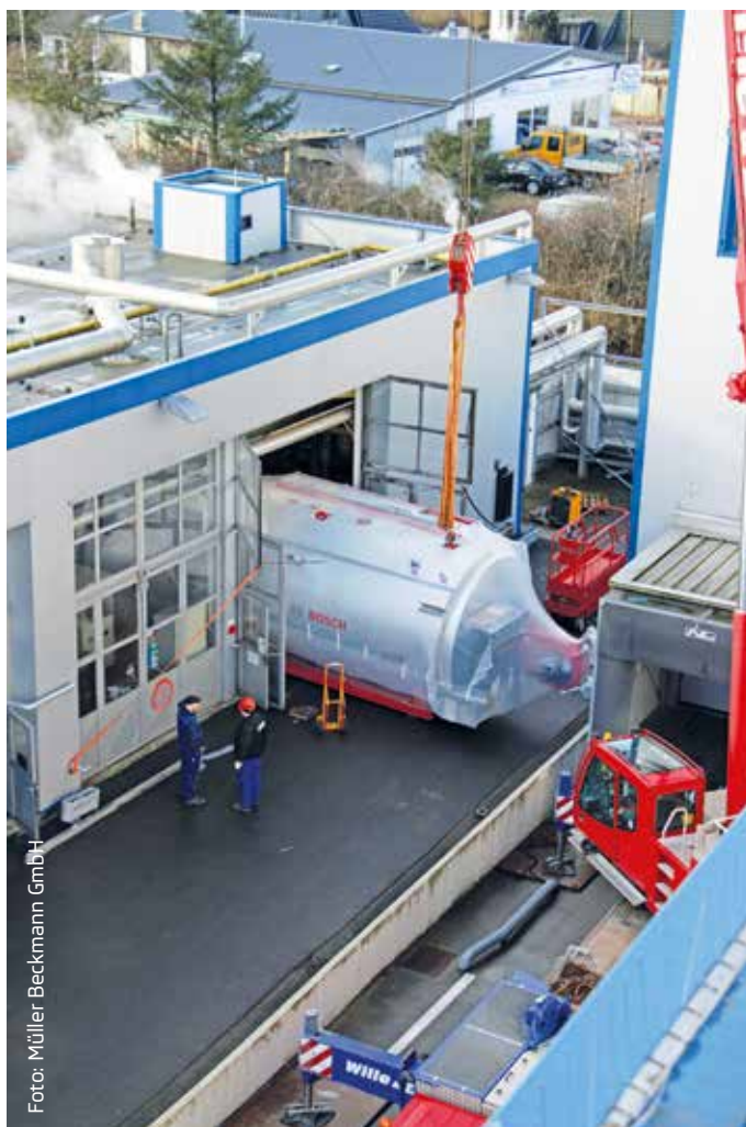
Abbildung 3: Einbringen des Hochdruck-Dampfkessels
