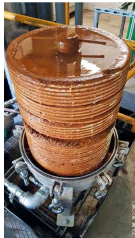
Abbildung 1: Modulfilter mit starken Korrosionsablagerungen
