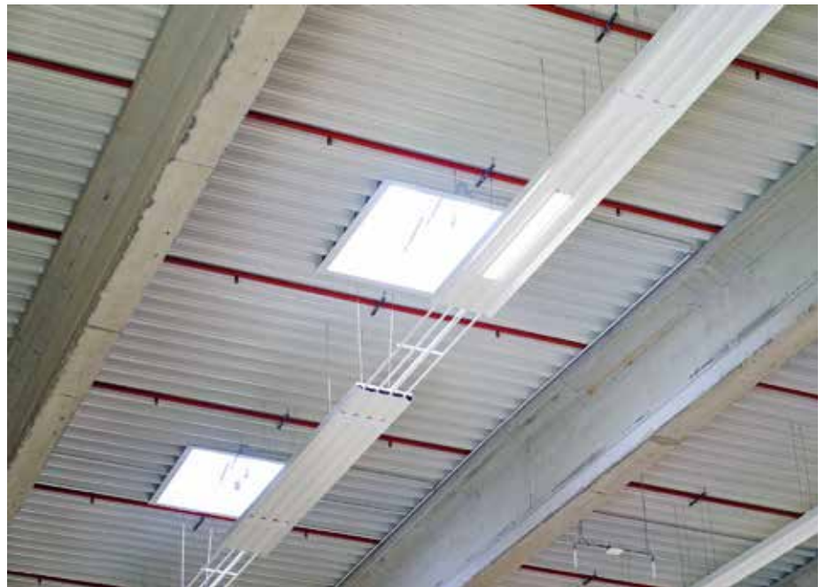
Abbildung 2: Die Deckenstrahlplatten wurden mit Baulängen bis 55 Metern realisiert.
