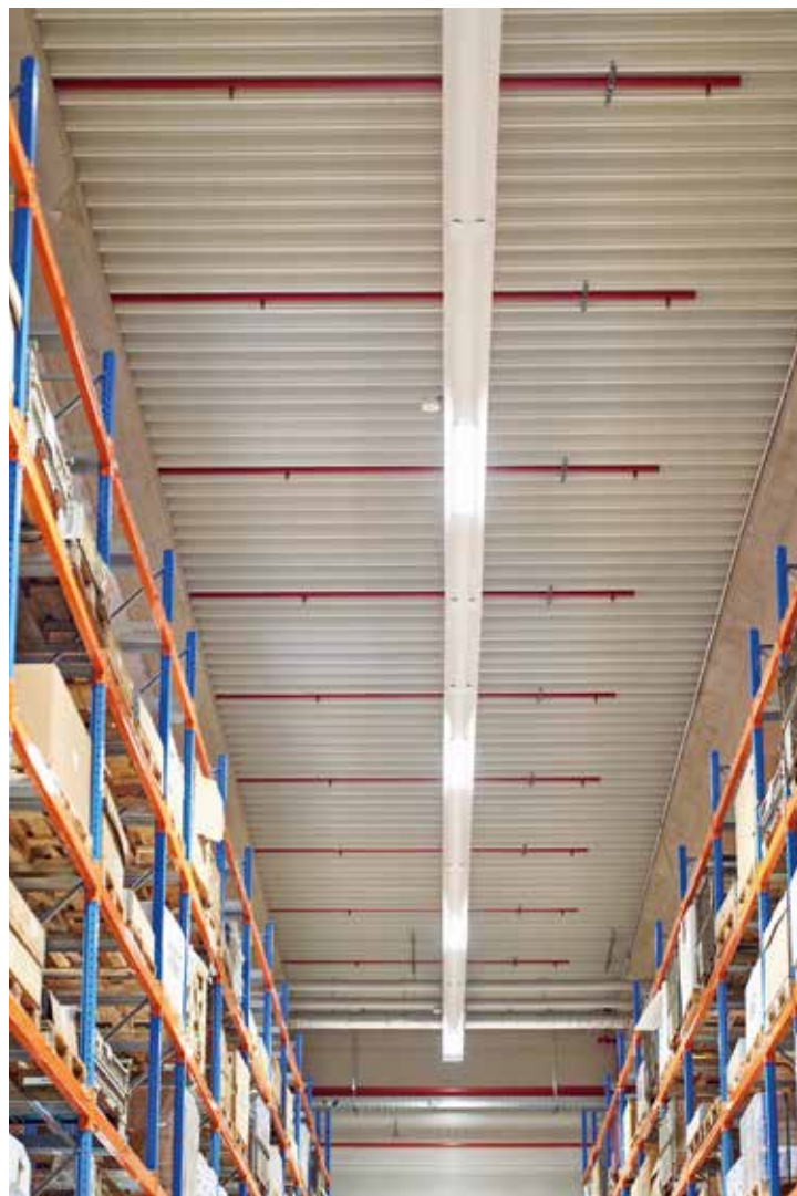
Abbildung 3: Mit Baubreiten von 310 mm und 510 mm wurden besonders schmale Deckenstrahlplatten montiert.
