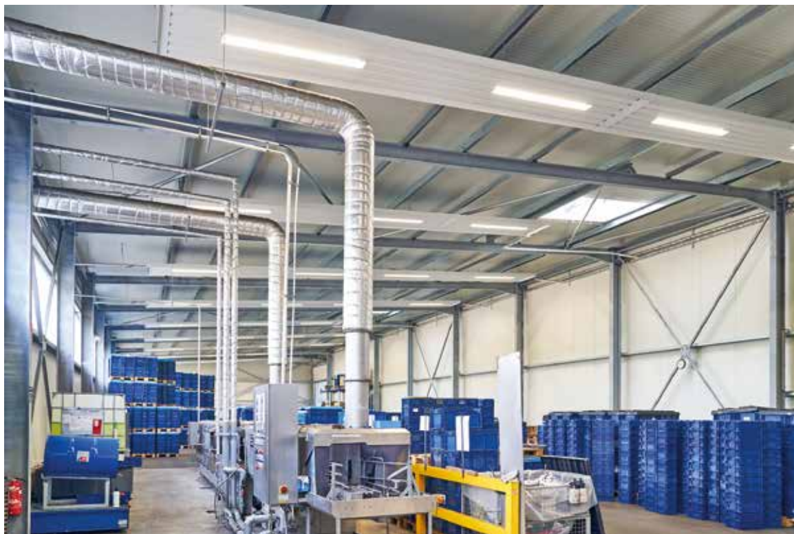
Abbildung 4: In der ersten mit Deckenstrahlplatten ausgerüsteten Technik- halle werden Transport- behälter gereinigt.
