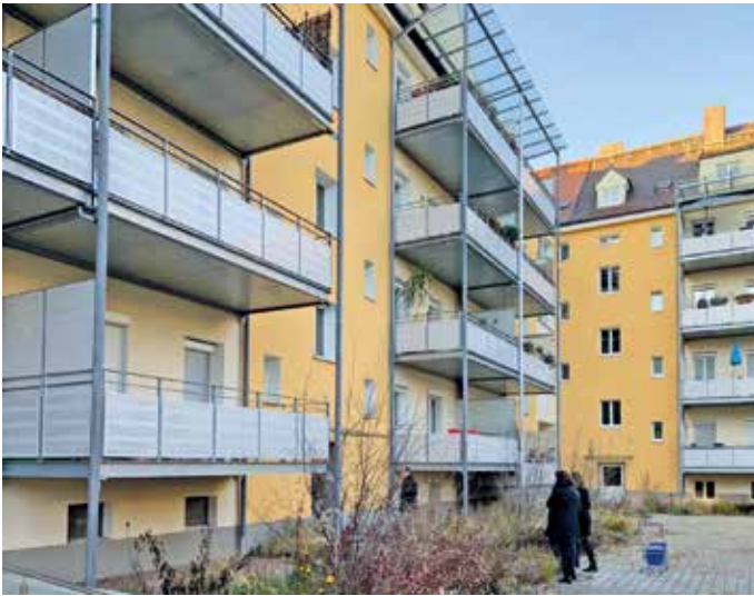
Nach einer Wasser-Beprobung in der Münchner Wohnanlage mit 55 Wohneinheiten wurde in mehreren Zirkulationsrückläufen eine Legionellen-Verkeimung festgestellt. Es musste schnell gehandelt werden.
