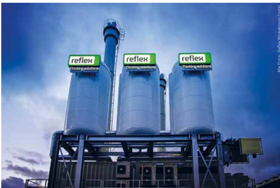
Drei Pufferspeicher wurden platzeffizient auf dem Dach des Unternehmens installiert.
